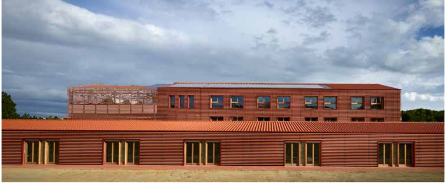
5. Scuola media a Riccione, di Pietro Carlo Pellegrini: il rivestimento frangisole in cotto protegge dai raggi solari diretti e favorisce la microventilazione della facciata (pubblicata su CiL 160 Scuola Italia) ©Mario Ciampi
