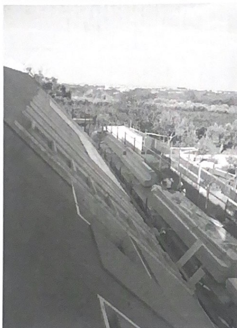
Fig. 15 - Casa C. Il montaggio della copertura.
