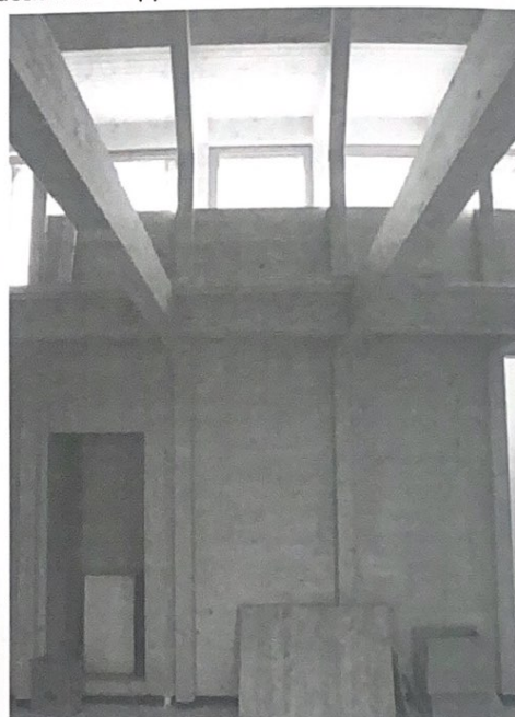
Fig. 16 - Casa C. La copertura dall'interno.
