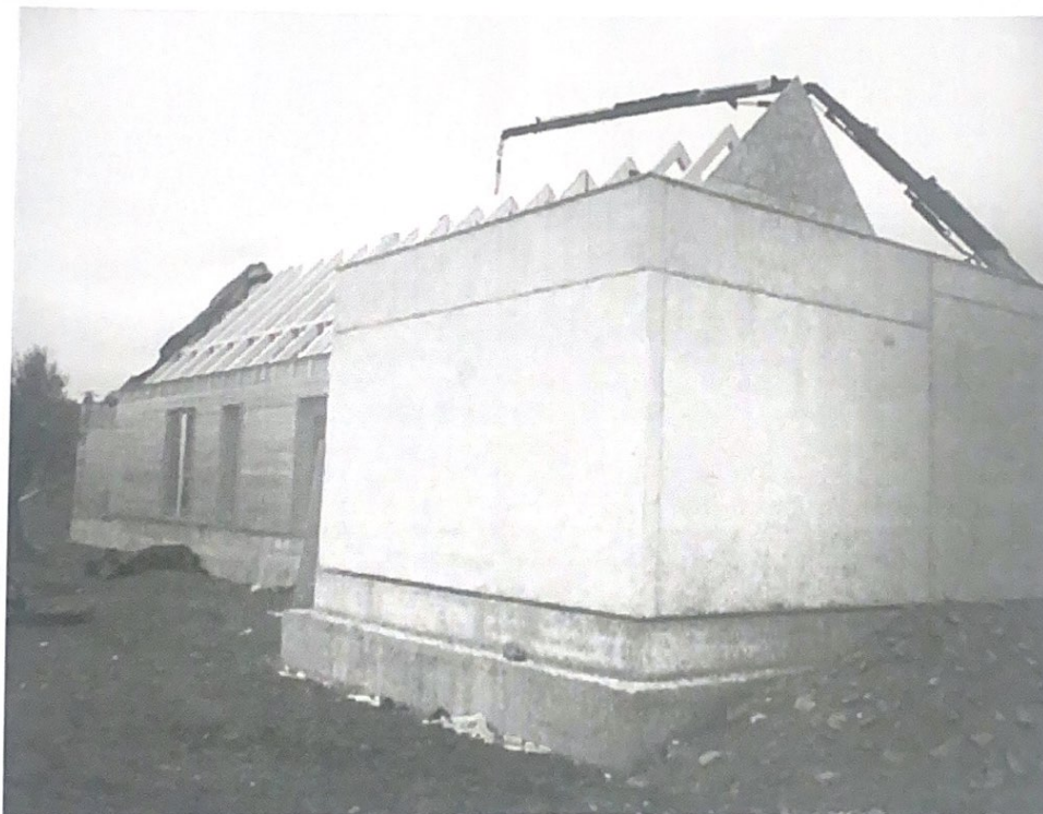
Fig. 14 - Casa C. Il cantiere dall'esterno.
