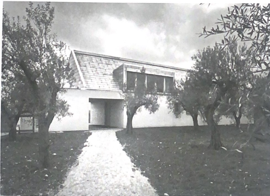
Fig. 18 - Casa C. l'accesso principale.
