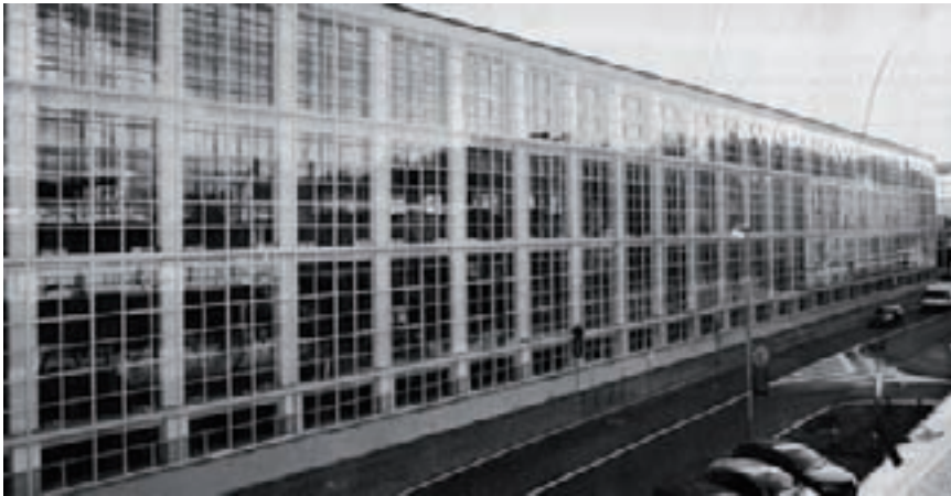
Luigi Figini e Gino Pollini, Stabilimento Olivetti, Officine I.C.O., Ivrea La facciata delle Officine dopo l'intervento di restauro (fonte: A. ZAPPA, Bentornata Utopia. Ex officine Olivetti di Ivrea , in «Costruire», n. 284, 2007)
