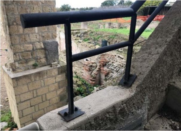
Figure 16: Tempio-Masseria del Gigante. The metal handrail of the staircase.
