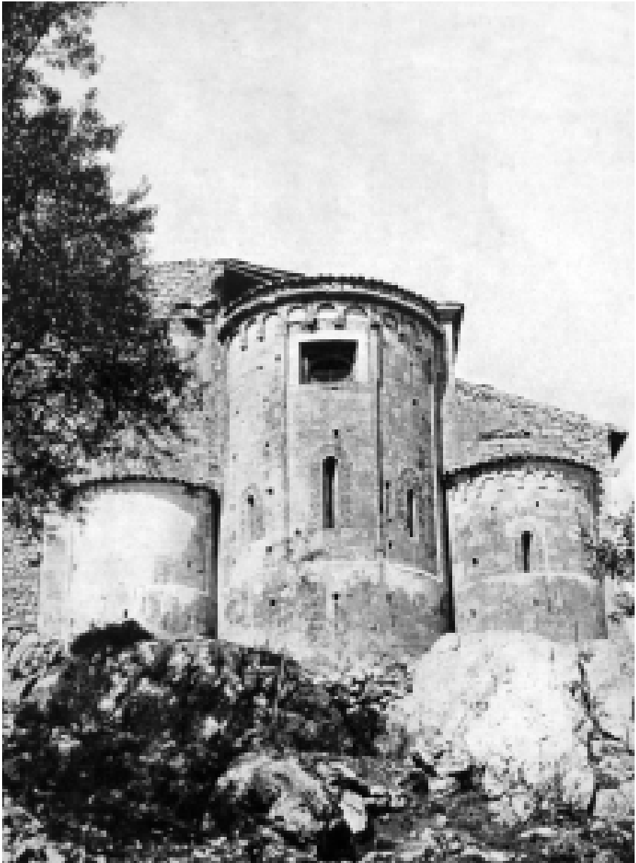
8. Bominaco, Santa Maria, stato delle absidi prima dei restauri (I. C. Gavini, 1927)
