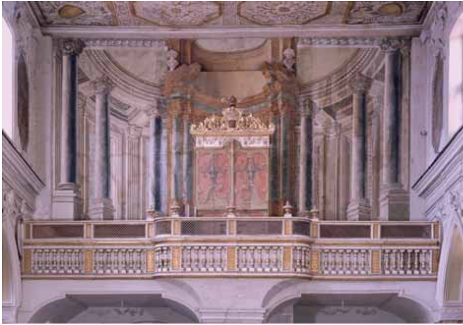
Tav. X – Napoli, Basilica di Santa Restituta, controfacciata, prospettiva di Arcangelo Guglielmelli.
