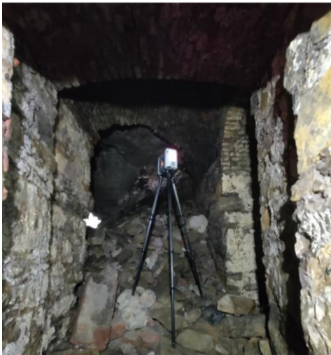
Fig. 3 e 4- L'unità laser scanner 3D Leica RTC360 nelle operazioni negli esterni e negli interni della fortezza (Marzo 2025)
