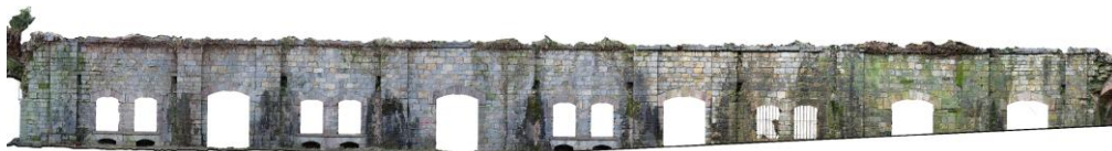
Fig. 6- Fronte principale del forte prospiciente il cortile alto, murature del piano terra, ortofoto da fotogrammetria
