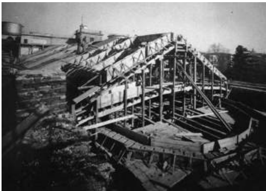
Figure 11. Martinotti, Building works for an attic in the Napoleonic Halls (1947). Pinacoteca di Brera, Milan. [Source: Fondazione Portaluppi, Archivio storico, folder Lavori , uncat.; ©FAI]
