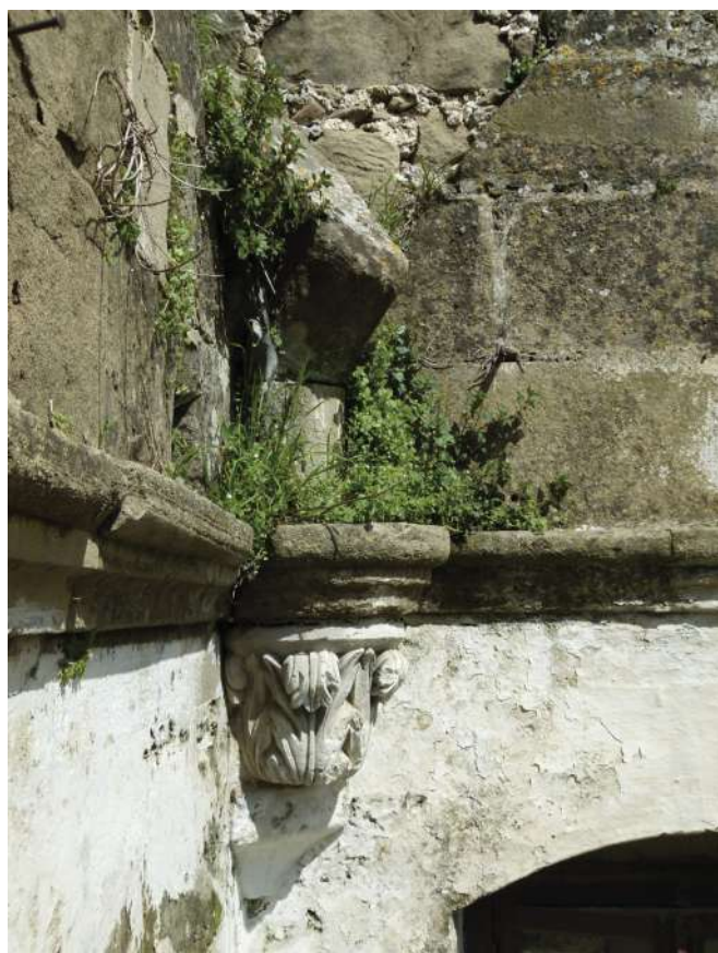
Fig. 12. Kalathenes. Retonta, angolo nord-ovest della corte centrale, peduccio e nervatura della crociera.
