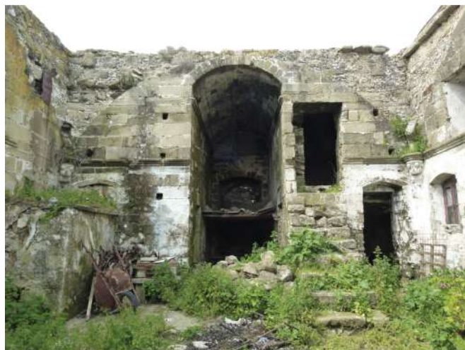
Fig. 11. Kalathenes. Retonta, prospetto ovest della corte centrale.
