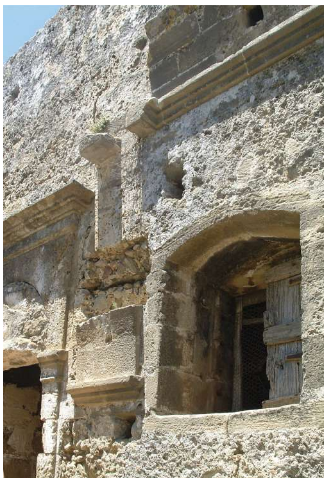
Fig. 10. Kalathenes. Retonta, prospetto sud, imposte di arco e di volta a botte e cornice modanata.
