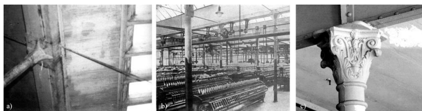
Figura 8 - a) particolare dei tiranti metallici del Cottonificio Udinese dell'Ancona; b) vista della sala tessitura del Cottonificio di Fiume Veneto; c) capitello in ghisa con motivi classici del Cottonificio Rorai.
