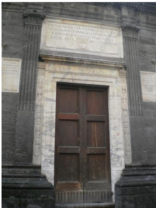
Figura 6 - La Cappella del Pontano dopo il restauro - Particolare del portale di accesso
