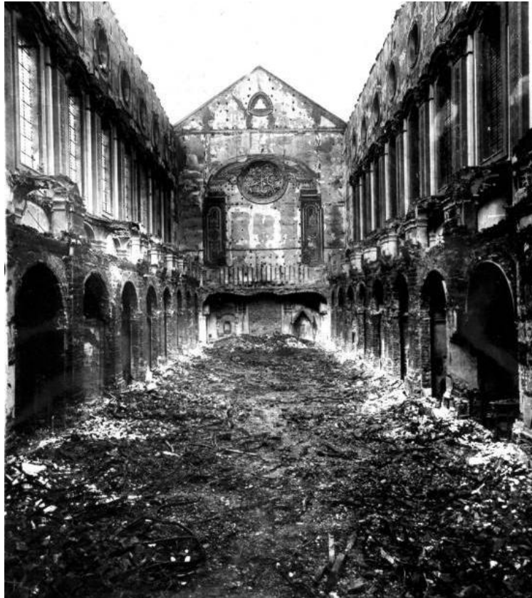
Figura 4 - L'interno di Santa Chiara dopo un bombardamento della Seconda guerra mondiale
