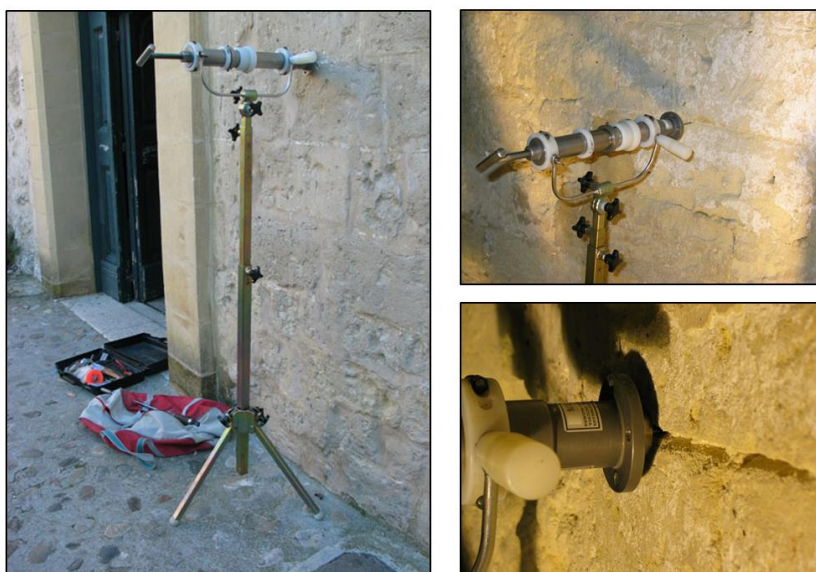
Figure 9-10-11. Strumento e fasi della prova.
