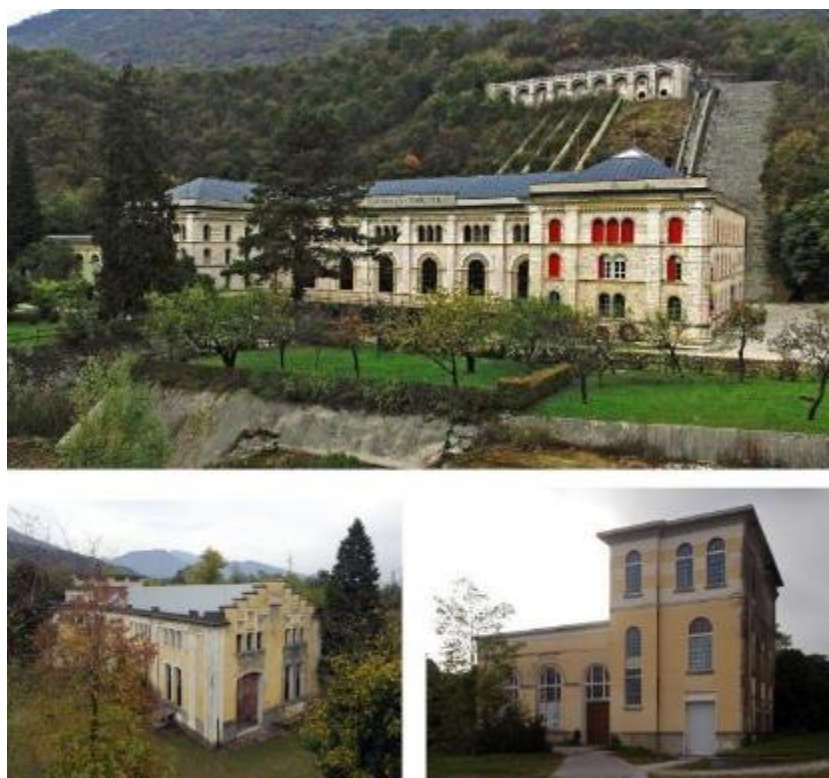
Figura 1 - Le tre prime centrali realizzate “in cascata” ovvero sfruttando un’unica canalizzazione, lungo il corso del Cellina. In alto: Malnisio, in basso a sinistra Giais e a destra Partidor. In esse è leggibile una progressiva evoluzione dei linguaggi architettonici e delle concezioni strutturali.
