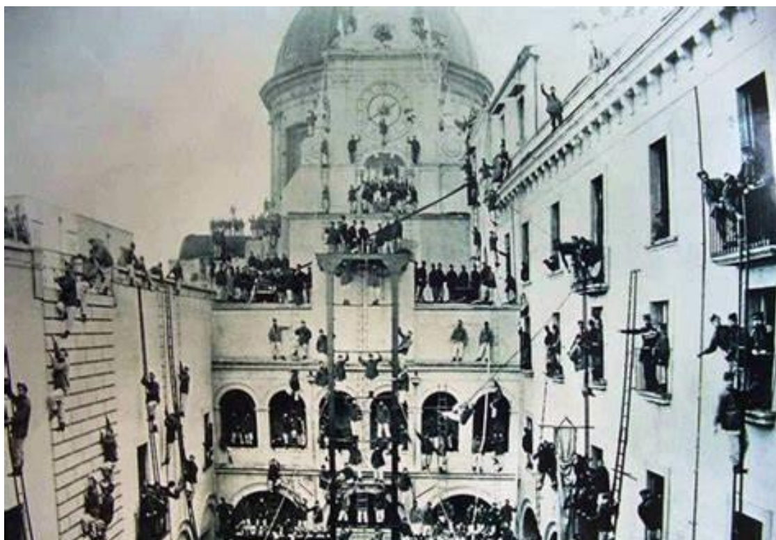
Figura 5 - L'ex convento della Pietrasanta diventa la prima caserma degli artigiani pompieri; oggi ospita il comando dei vigili del fuoco di Napoli
