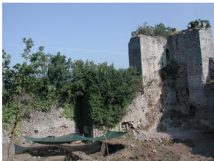
Figura 5 - Torre Ovest con cinta muraria oggetto di scavi archeologici. Foto di Paolo Peduto.
