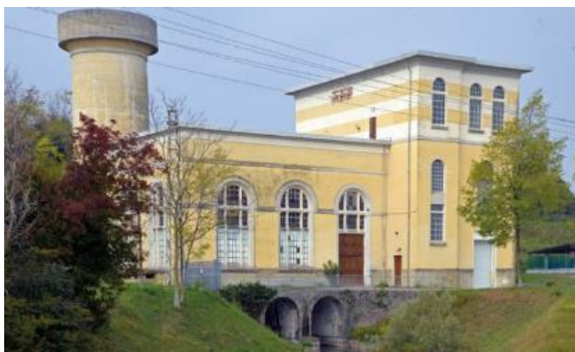
Figura 6 - La centrale del Partidor vista da Sud-Est dove si scorgono le bocche di uscita dell'acqua dalle turbine e il canale di scarico.
