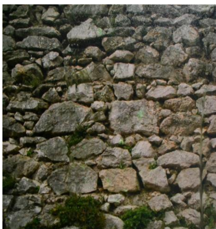
Figura 11 - Tessitura in pietra calcarea irregolare tratto murario svevo, foto di Catello Grimaldi.
