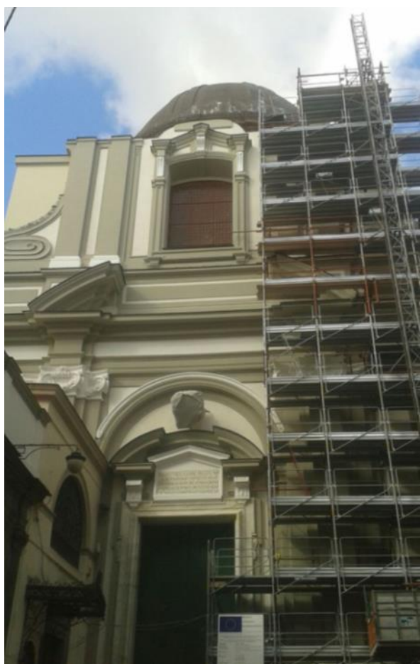
Figura 8 - La facciata di Santa Maria Maggiore della Pietrasanta durante i lavori di restauro
