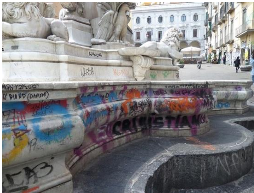
Figura 1 - Fontana di Carlo II in Piazza Monteoliveto, Napoli.
