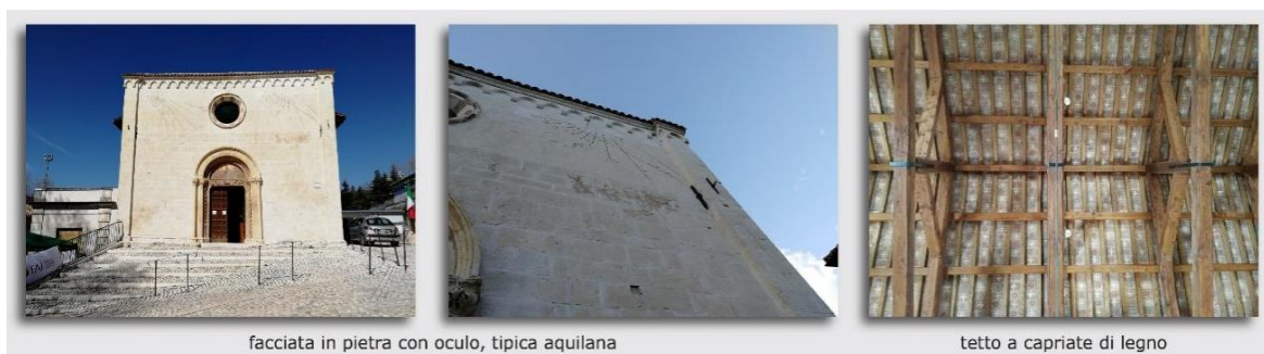
Figura 1. Valori storico costruttivi della Chiesa di San Vito
