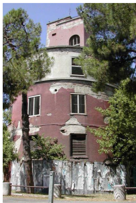
Fig. 6 Particolare del fronte sud (anno 2001)
