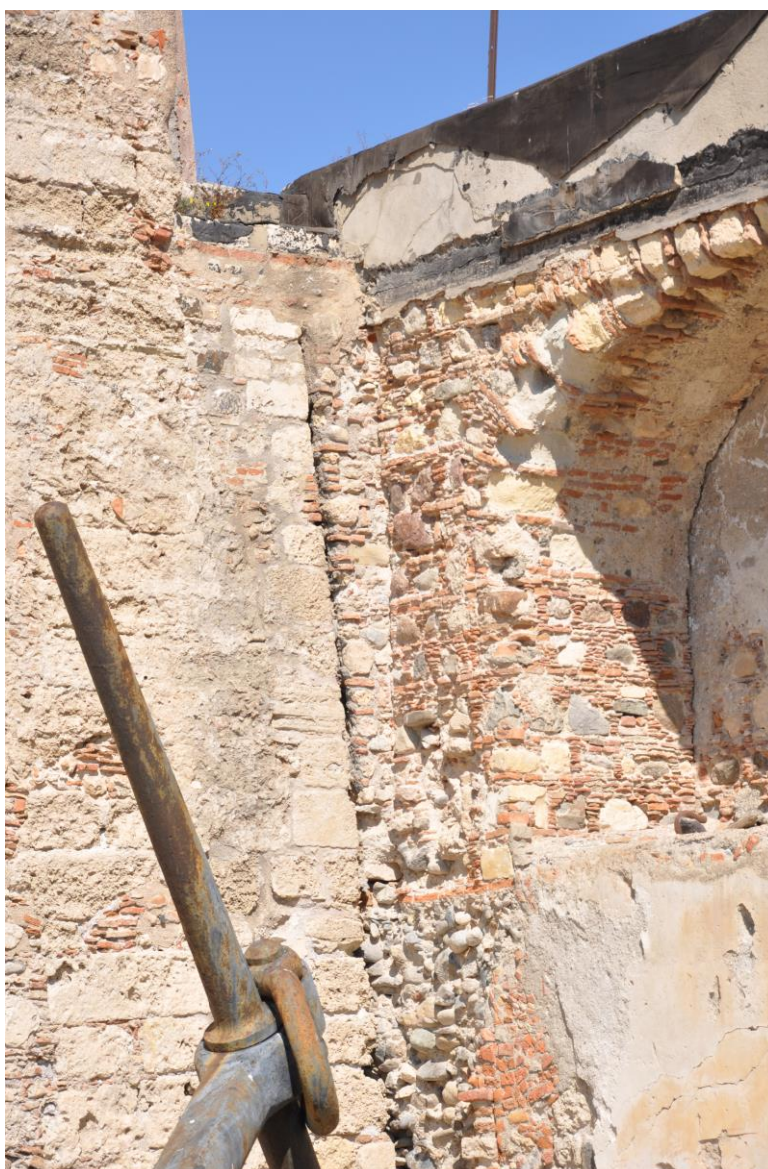
Fig. 13. Dettaglio dell'appoggio della muratura nord del forte del SS. Salvatore sul cantonale del muro nord-est di Forte Campana
