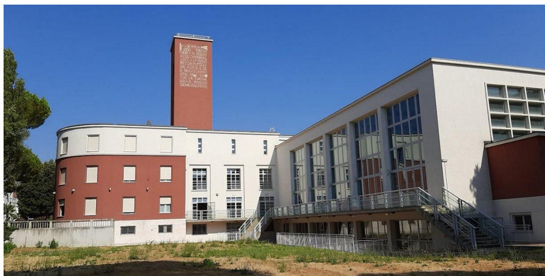
Fig. 10 Vista dal campo sportivo dopo il restauro (anno 2017)
