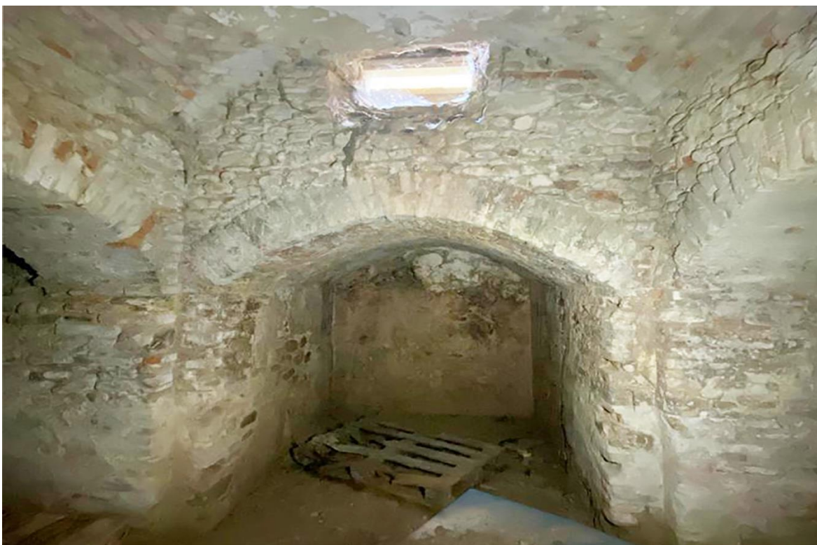
Figura 5. La cantina, in muratura mista, mostra ancora la copertura originaria.
