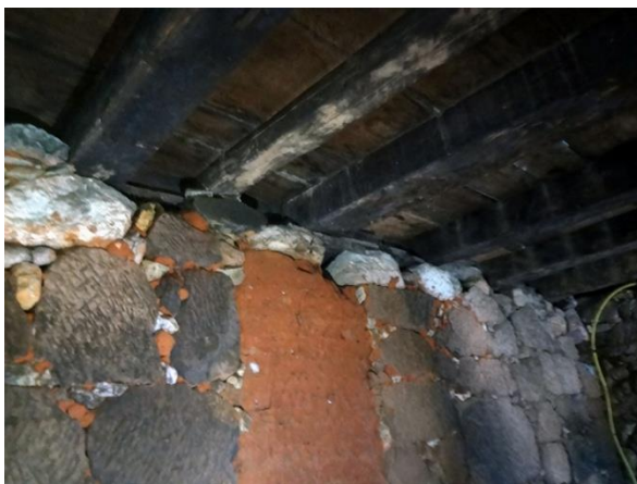
Figura 6. Detalhe das paredes em moledo no porão e do piso do pavimento principal. Fonte: Acervo dos autores, 2022.
