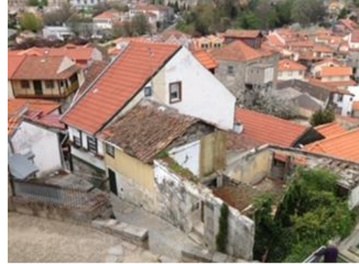
b) Main façade
