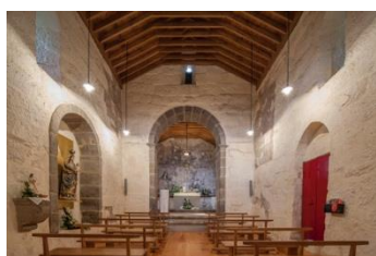
Figura 19. Interior da Igreja de S. Mamede de Vila Verde, depois das obras.
