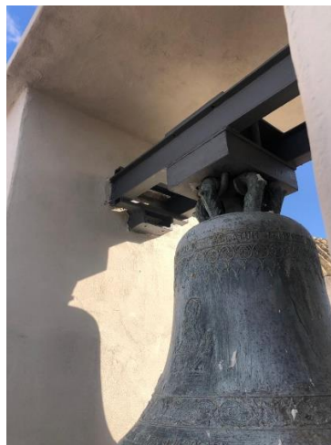
Figura 11. Dettaglio della muratura post intervento
