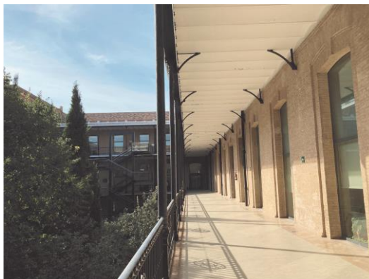
Figura 8. Detalle de uno de los patios interiores
