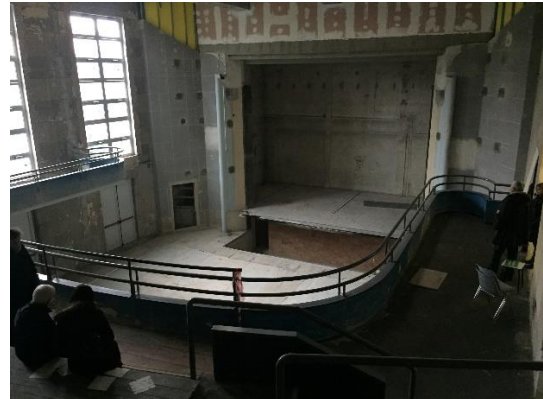
Fig. 13 Cinema dopo la rimozione degli arredi (anno 2019)
