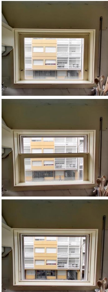
Figura 6: Vão da cozinha
