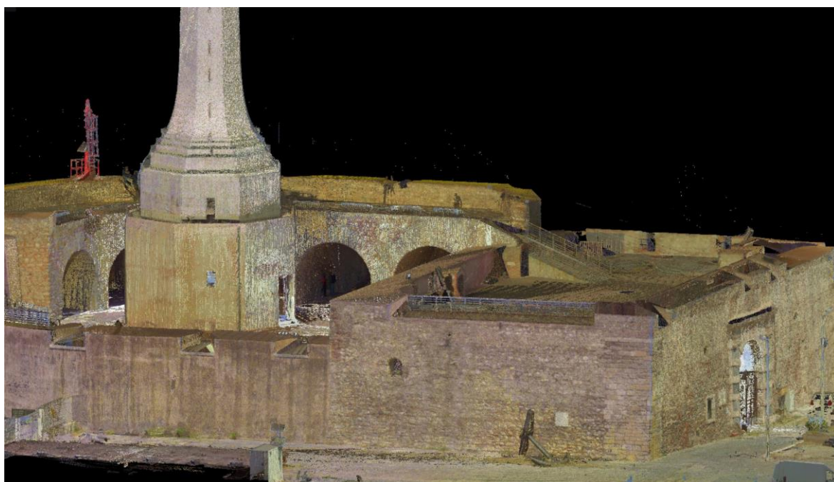
Fig. 3. Nuvola di punti del forte Campana visto da sud.
