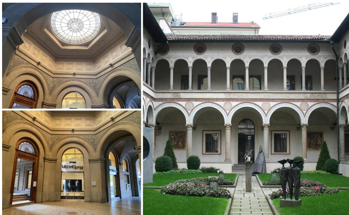
Figura 5. A sinistra, il passaggio di Santa Marta con particolare dell'esagono e del lucernario e a destra, il chiostro con alcune delle opere d'arte contemporanea (@autori, 2021).
