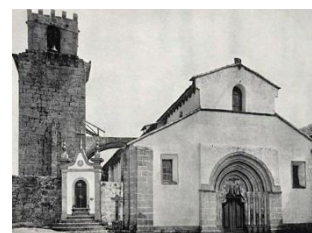
Figura 9. Igreja do Mosteiro de Travanca antes da intervenção da DGEMN.
