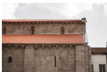
Figura 25. Coberturas da Igreja do Mosteiro de Travanca, depois das obras.
