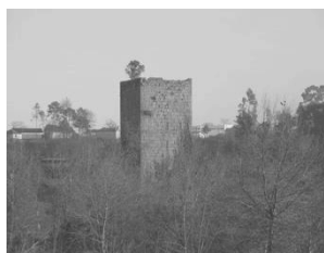
Figura 1. Torre de Vilar.
