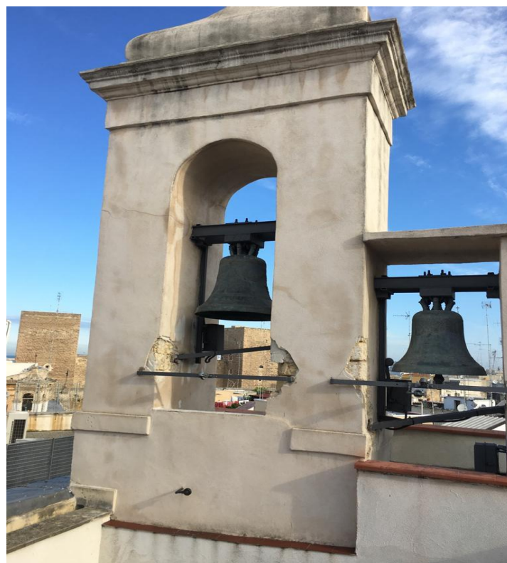
Figura 3. Campanile a vela ante dell'intervento
