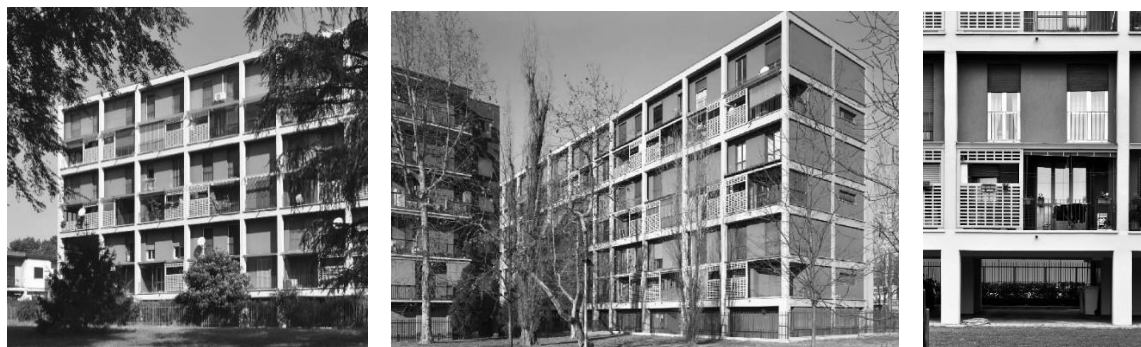
Figure 2. A sinistra/centro: Scorcio sul giardino-fotografia di Suriano, Stefano, 2016; a destra: Foto piano di dettaglio del prospetto sud con in evidenza il reticolo strutturale accentuato dall'arretramento delle superfici di tamponamento-fotografia di Suriano, Stefano 2016. (Archivio Civico, Milano).
