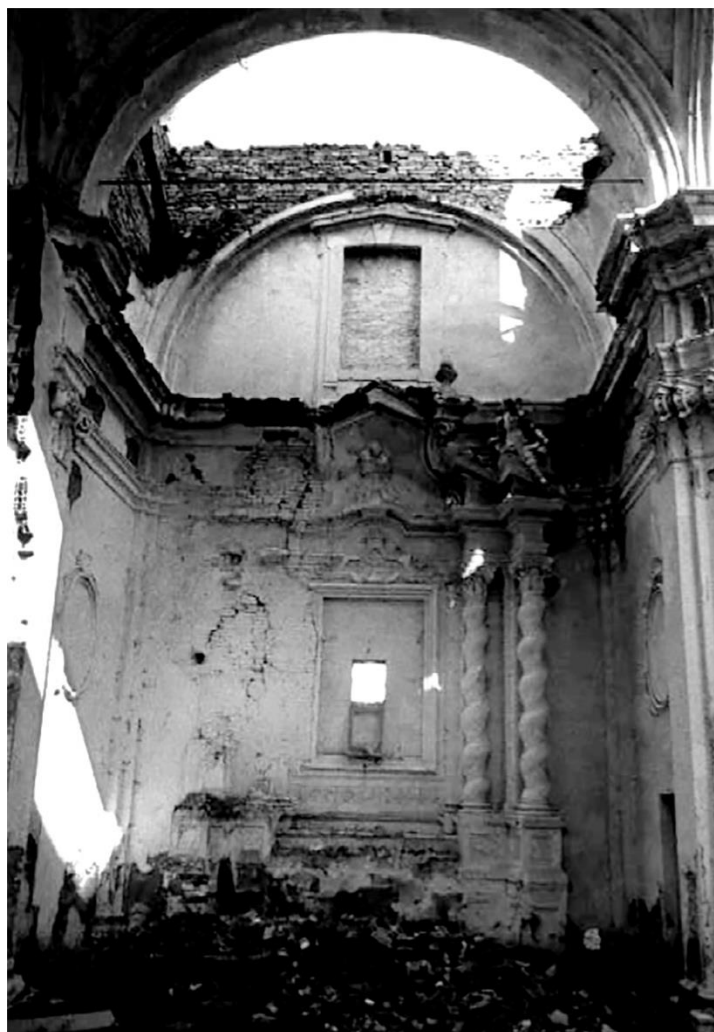
Figura 3. Cappella laterale negli anni ottanta del Novecento.
