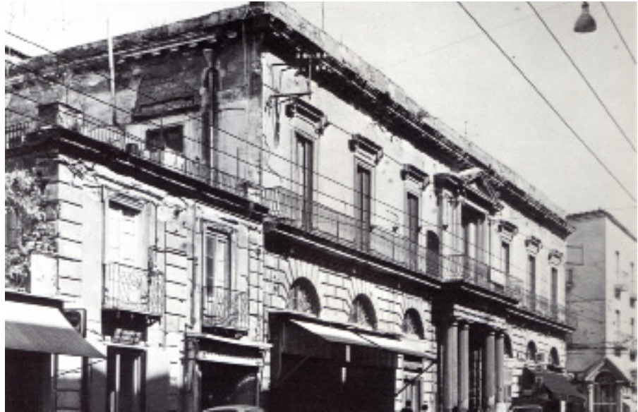
Fig. 4. S. Giovanni a Teduccio. Villa Faraone (1855). Facciata sulla strada.
