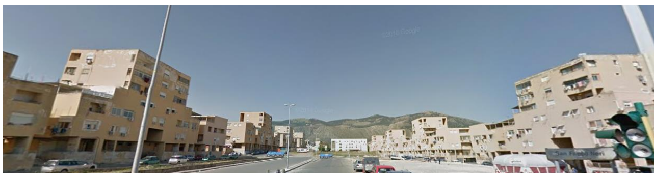
Figura 1 | Nel quartiere Z.E.N. di Palermo gli edifici presentano una stessa conformazione, rendendone difficoltosa la riconoscibilità. Viale Sandro Pertini, Palermo. Fonte: Google Street View
