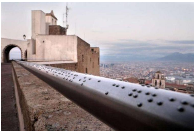
Figura 11 | Indicazioni in braille integrate nei corrimani. Progetto “Follow the shape” di Paolo Puddu a Castel Sant’Elmo, Napoli Fonte: https://www.napolidavivere.it/wp-content/uploads/bfi_thumb/santelmo-599x400-6evgt8agnromd988mtrw8plwm4mzsje97iebzvstys.jpg
