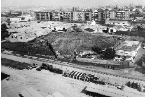
Fig. 6- Il fortino nella condizione precedente le operazioni di scavo, 1988 (ASABAPNa, b. 4/373, n. 48437 F)
