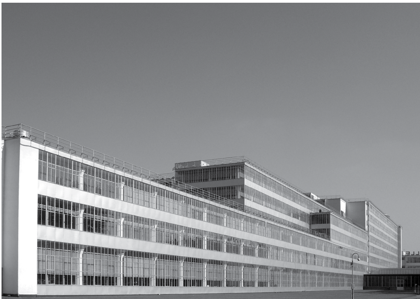
3. Rotterdam (Olanda). Fabbrica Van Nelle (1927-1931, Brinkman & Van der Vlugt); la facciata sud dopo il restauro ad opera dello studio Wessel de Jonge Architects (foto Paola Ascione, 2008).
