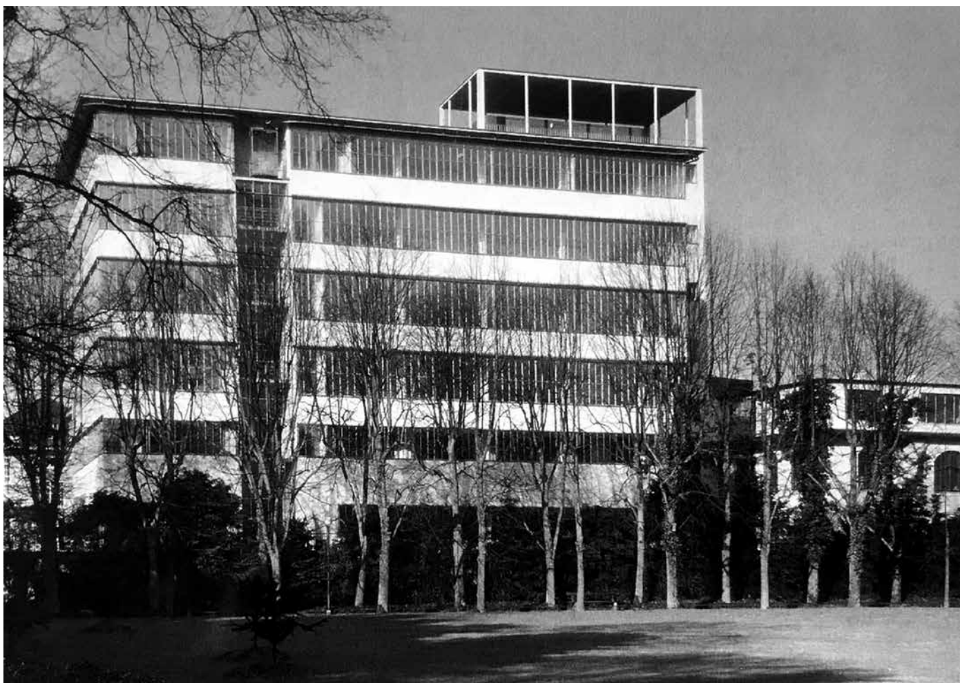
5. Basilea (Svizzera). Laboratori Hoffmann-La Roche (1937, Otto Rudolf Salvisberg; da Franz Graf, Yvan Delémonthey, Histoire et sauvegarde de l'architecture industrialisée et préfabriquée au XXe siècle , Presses Polytechniques Romandes, EPFL, Losanna 2020).
