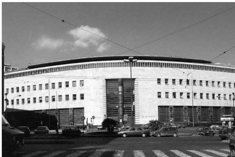
Il palazzo delle Poste, veduta.
