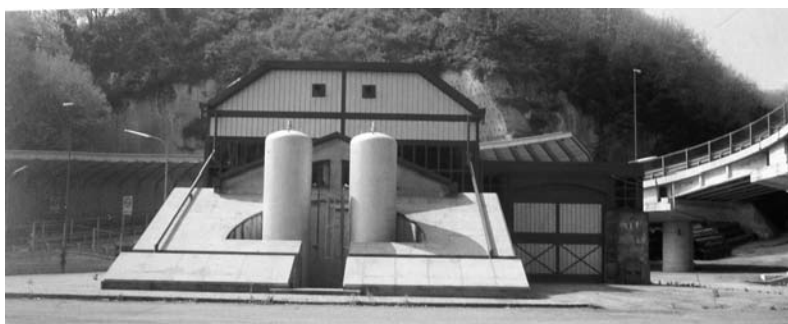
Centrale di sollevamento delle acque Aman allo Scudillo.
